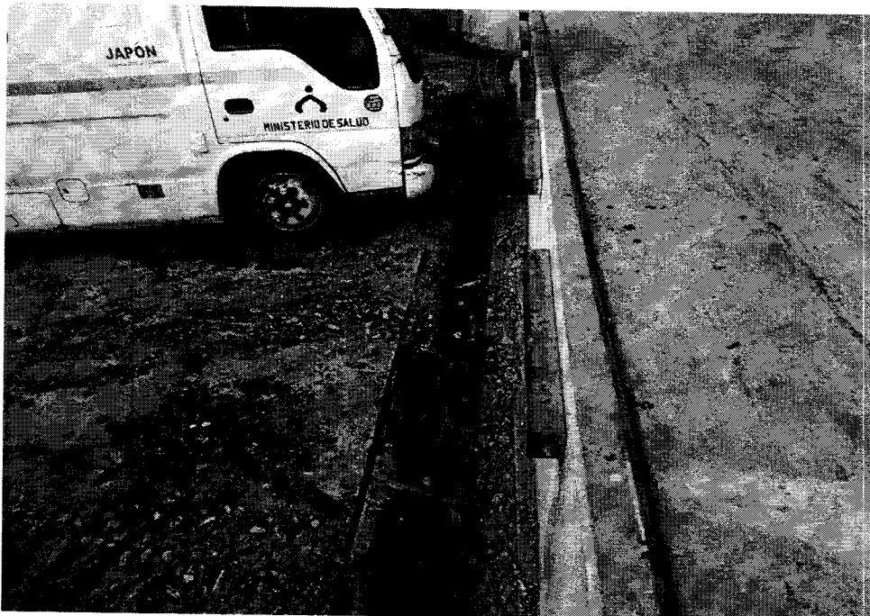
Desmontado de rejillas en todo el perímetro de las salas a intervenir, se nota la presencia de vehículos malogrados interfiriendo en zonas que no se pueden desocupar.
